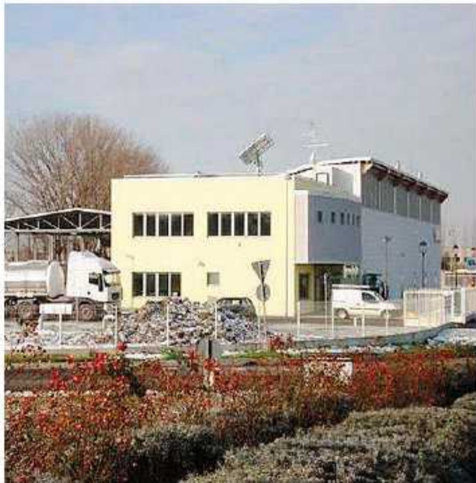
La centrale di En. Cor.
