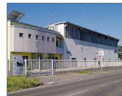
LA CENTRALE DELLA DISCORDIA L'esterno della centrale Eva, sede di En.Cor in via Pio la Torre, stessa via e civico della Soer
